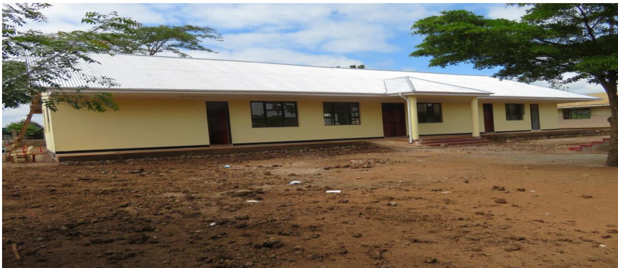
1.3 Picha ya Ujenzi wa Jengo la Utawala katika Shule ya Sekondari Naura, Kata ya Lemara.
