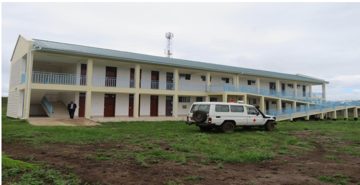
1.4 Picha ya Mradi wa ujenzi wa OPD katika Hospitali ya Wilaya uliopo Njiro, Kata ya Engutoto.
